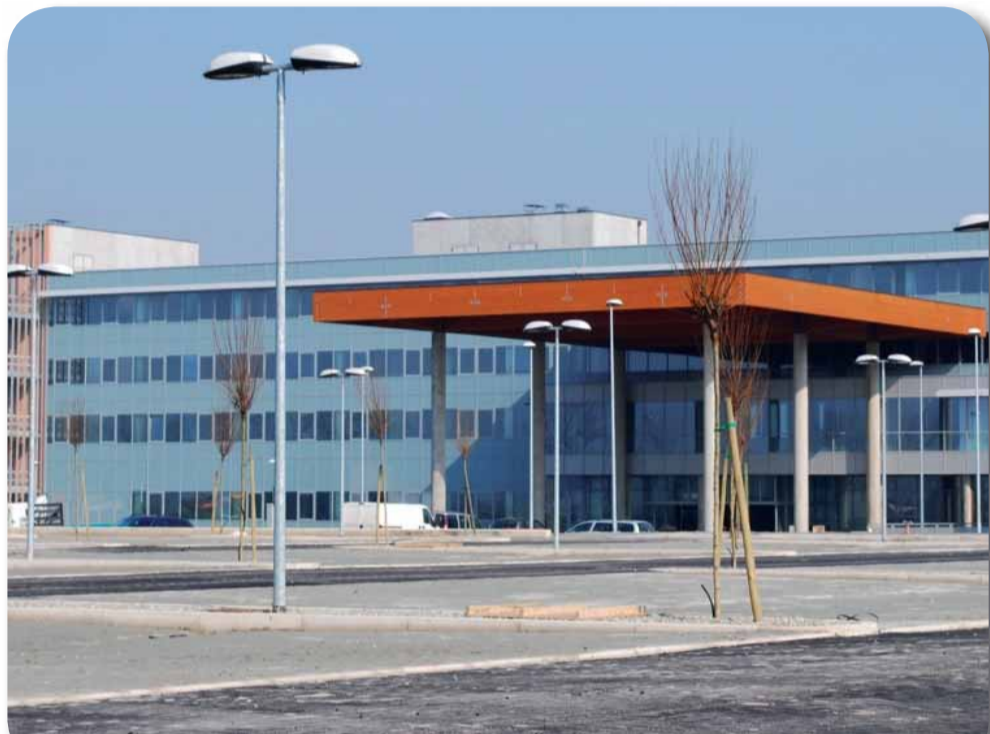
l'ingresso visitatori del nuovo ospedale di Cona
