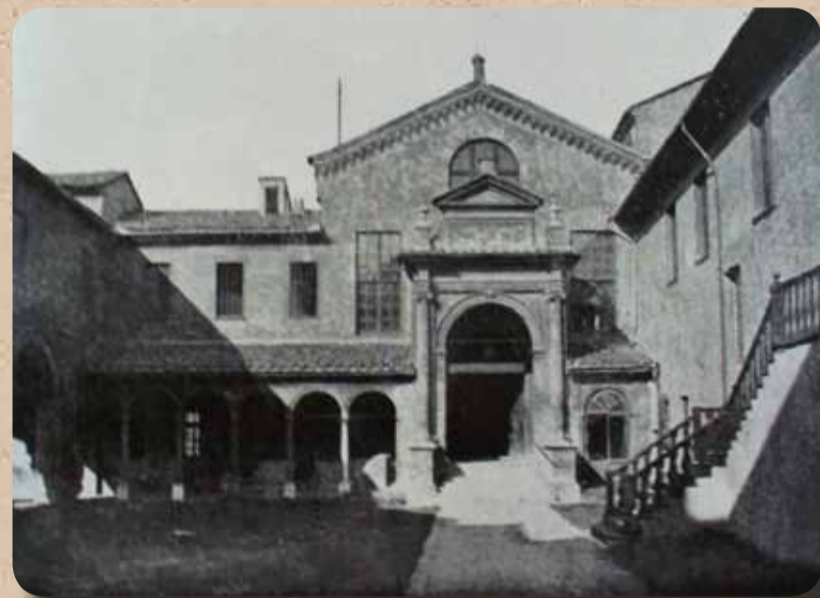
il cortile d'ingresso: l'accesso alla Sala Alta e la scalinata della Sala Donne
