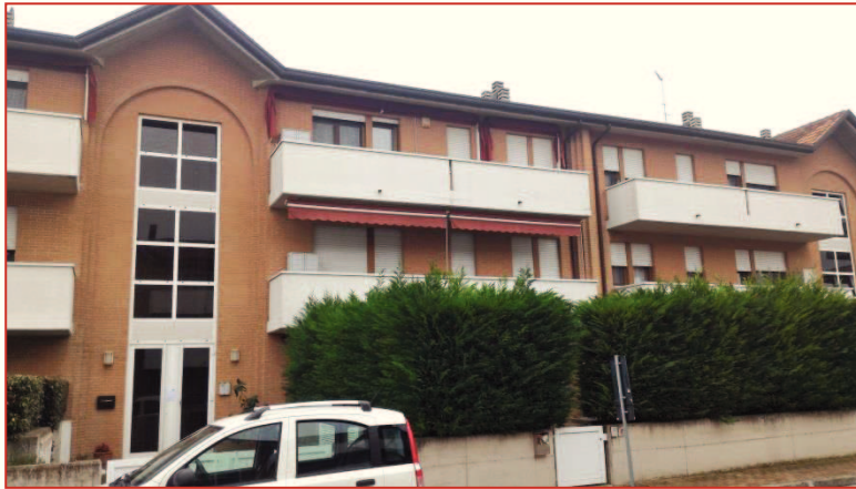
FOTO: vista dell'abitazione, posta al 1° piano
