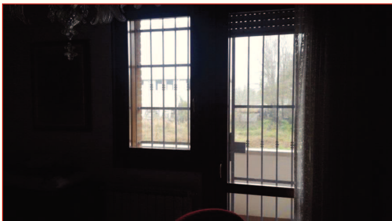
FOTO : particolare della grata anti-intrusione
