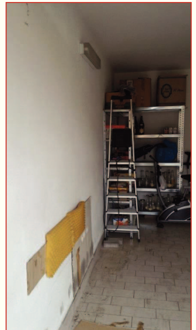
FOTO: particolare interno garage
