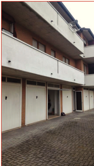
FOTO: vista del garage oggetto di valutazione
