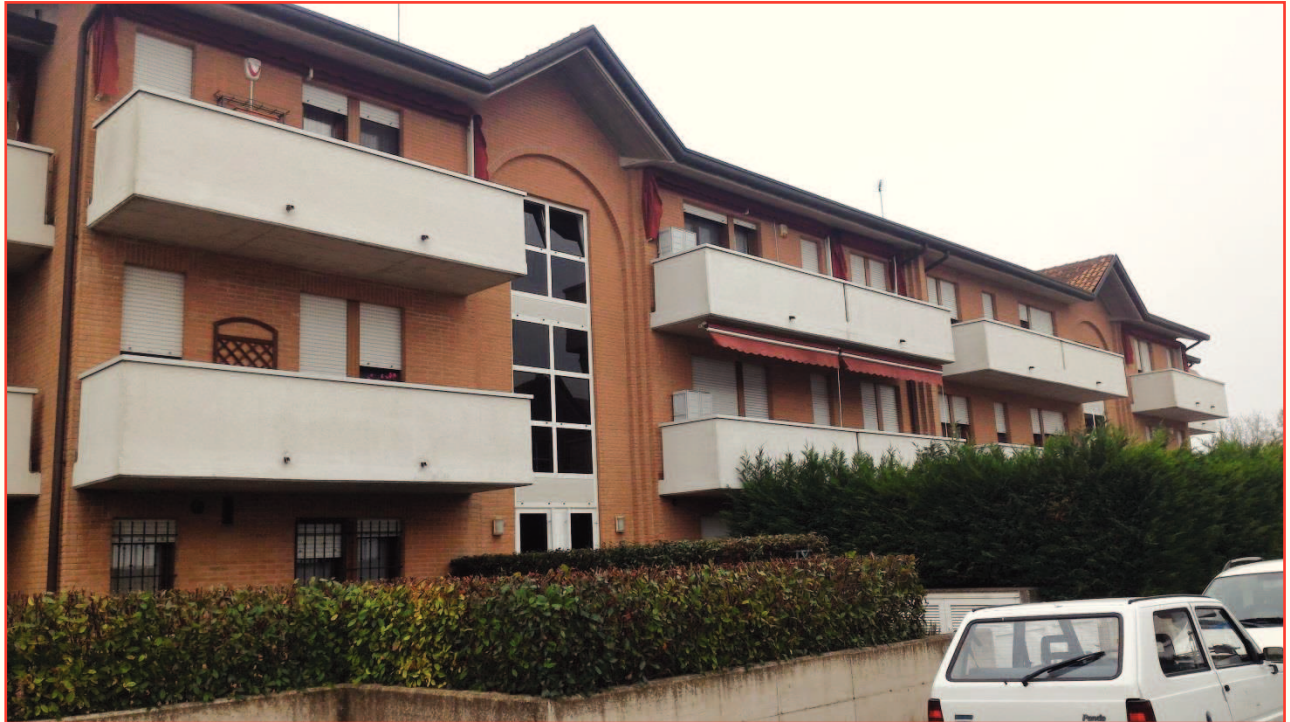
FOTO: Facciata dell'immobile ubicato in via Fenilnuovo n° 89/E, a Ferrara
